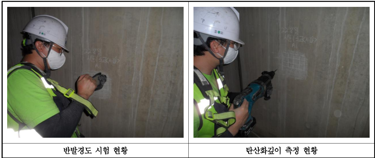
【사진 14.4.1】 콘크리트 내구성조사 현황
