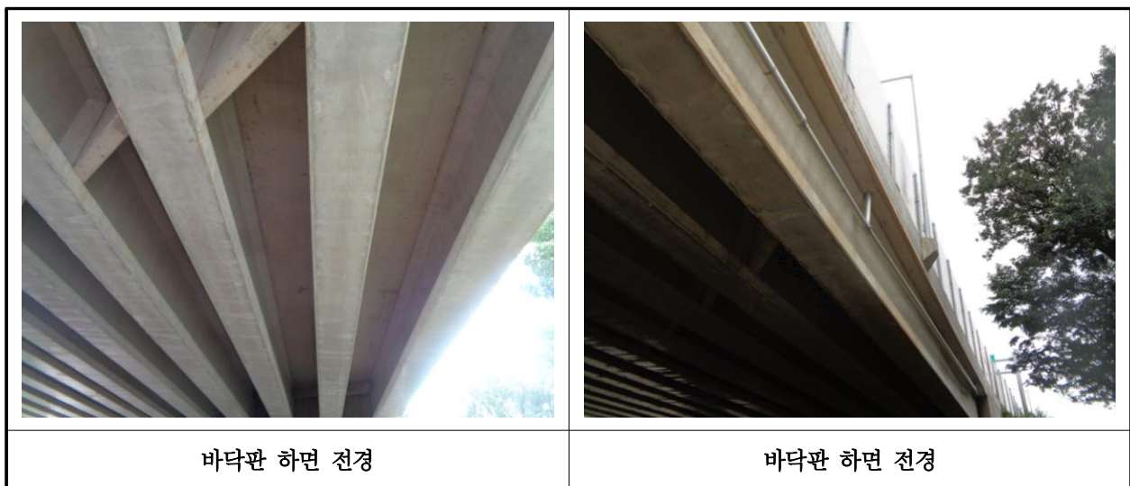
【사진 14.3.23】 바닥판하면 전경
