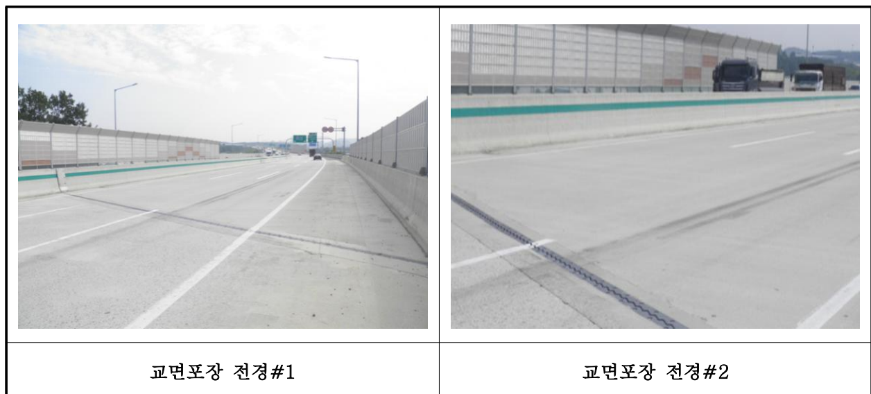
【사진 14.3.17】 교면포장 전경
