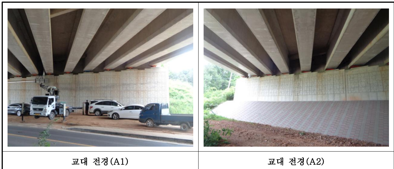
【사진 14.3.8】 교대 전경
