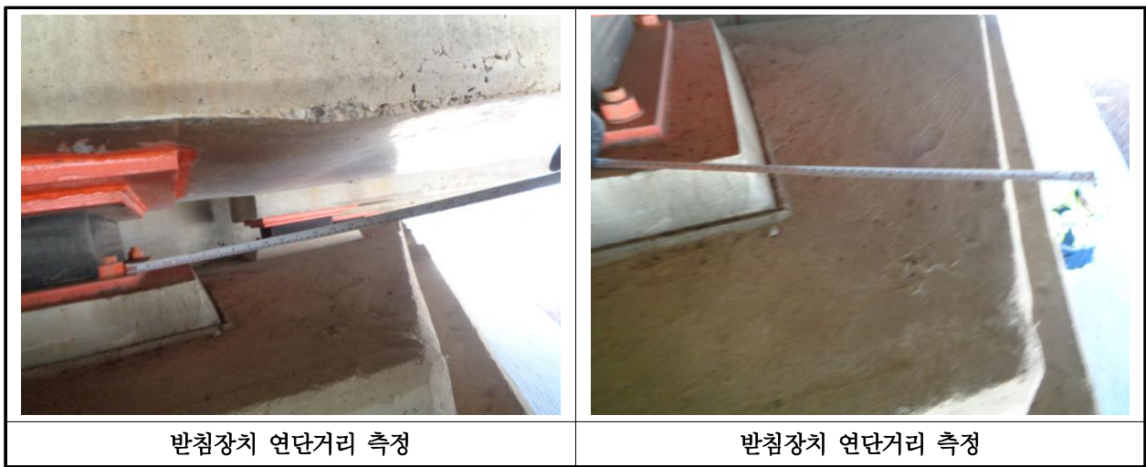
【사진 14.3.12】 교량받침장치 연단거리측정
