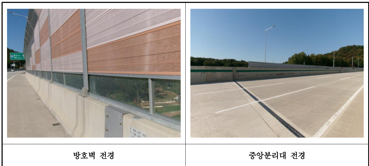
【사진 14.3.42】 방호벽 및 중앙분리대 전경
