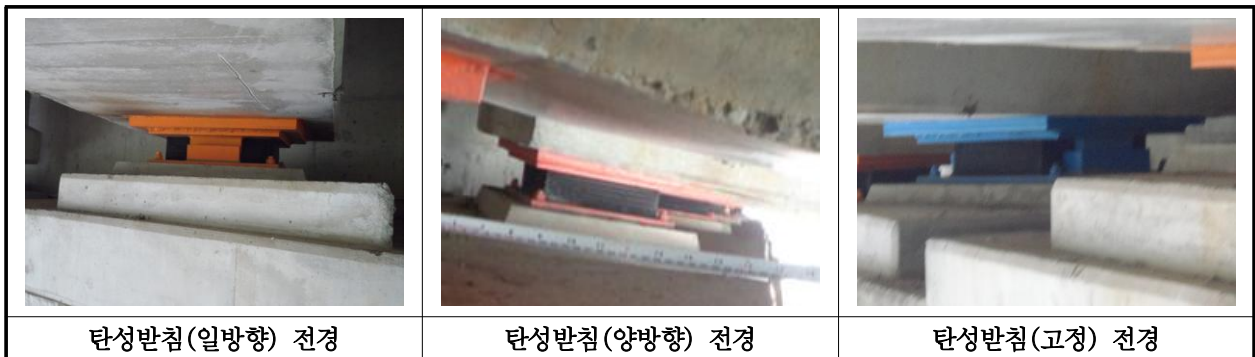
【사진 14.3.31】 교량받침 전경
