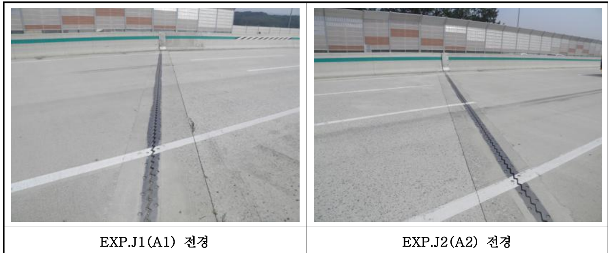
【사진 14.3.14】 신축이음장치 전경
