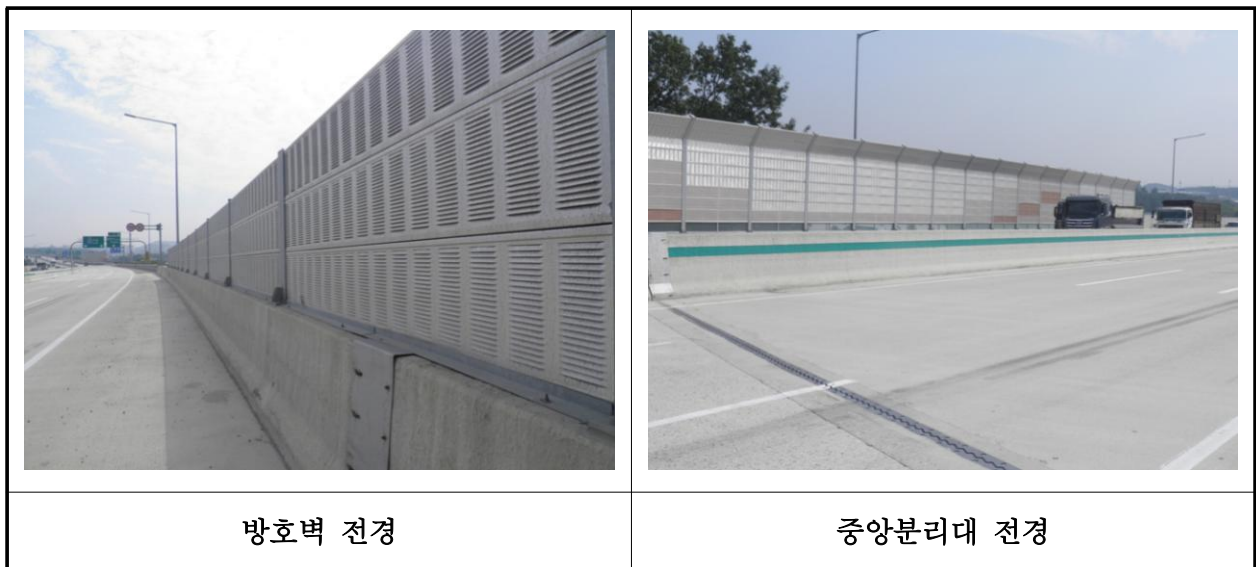
【사진 14.3.21】 방호벽 및 중앙분리대 전경
