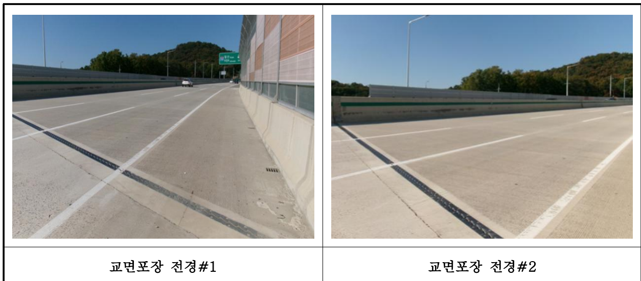
【사진 14.3.38】 교면포장 전경
