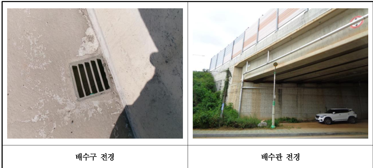
【사진 14.3.40】 배수시설 전경
