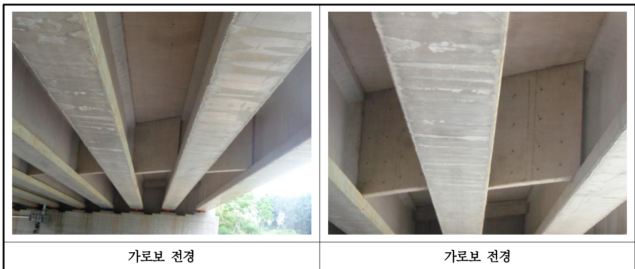
【사진 14.3.6】 가로보 전경
