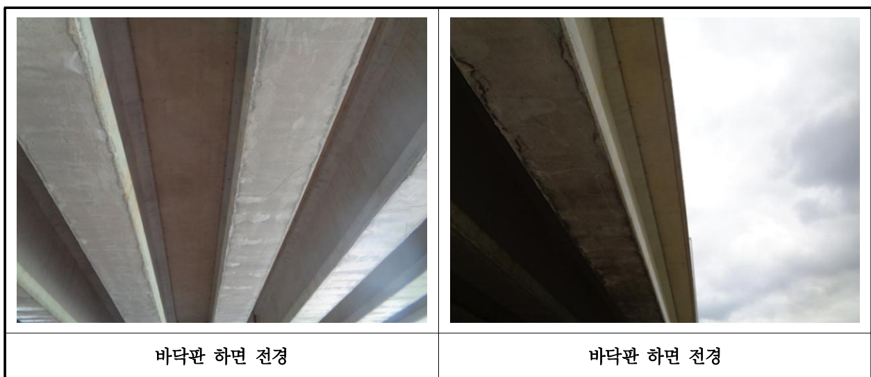
【사진 14.3.2】 바닥판하면 전경
