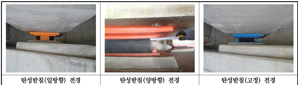
【사진 14.3.10】 교량받침 전경
